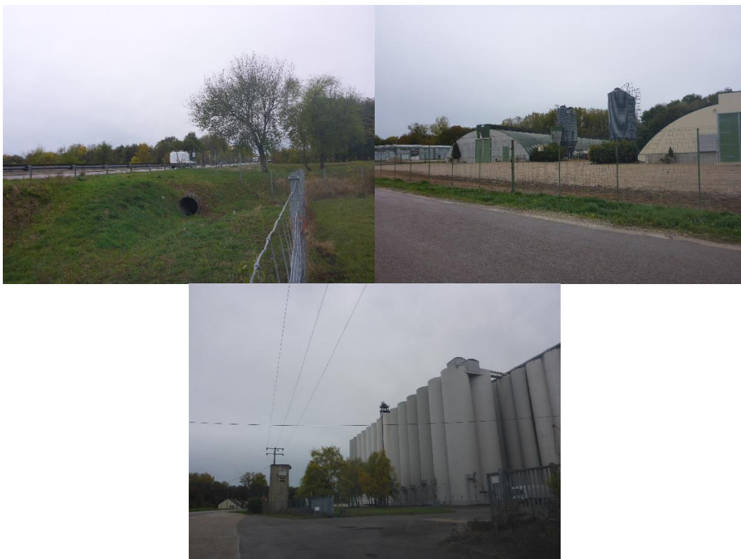
Figure 6 : Photos des installations présentes dans le PPE
